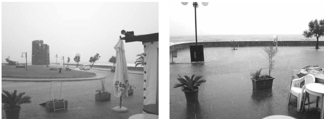
Figg. 17 – 18, Particolare della zona del lungomare soggetto a fenomeni di allagamento.
